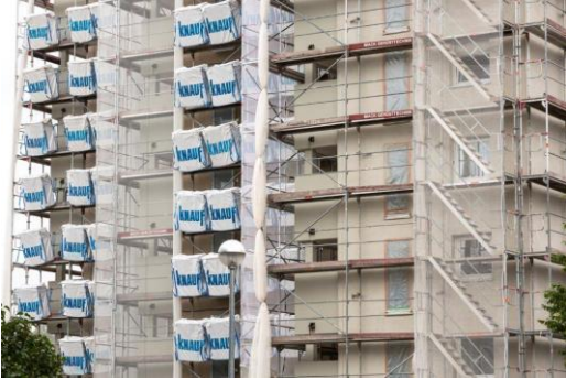
Die außen hängenden IMBAGs sorgen auf dem Gerüst für freie Wege und sichere Begehbarkeit. Der Dämmstoff ist gut gegen Wind und Wetter, aber auch gegen Diebstahl und Vandalismus geschützt. (Foto: Knauf/Duckek)
