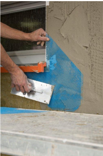
Die Qualität des Wärmedämm-Verbundsystems bestimmt sich auch an Details wie den Anschlüssen oder Fenstereinfassungen, die hier gerade ihr diagonales Armierungsgewebe erhalten. (Foto: Knauf/Duckek)
